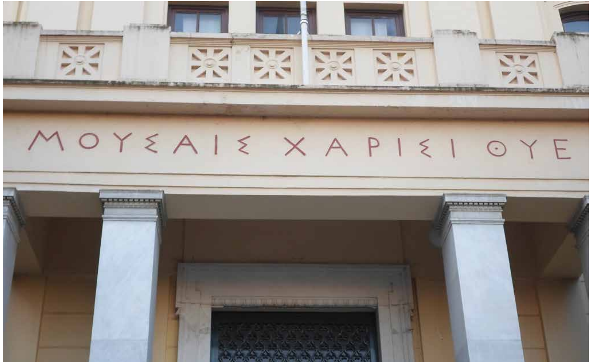
Είσοδος Παλαιού Κτιρίου Φιλοσοφικής Σχολής
