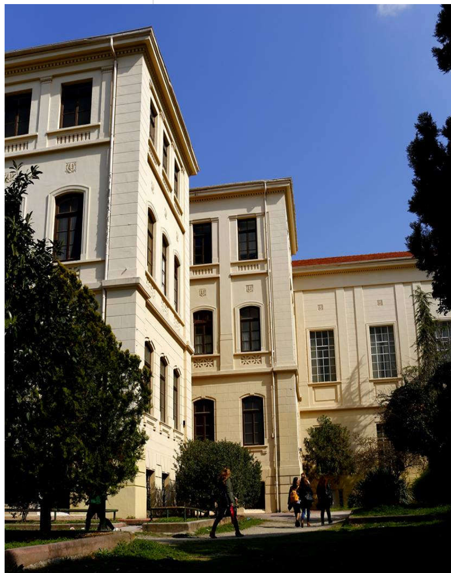
Αίθριο, Κτίριο Παλαιάς Φιλοσοφικής Σχολής
