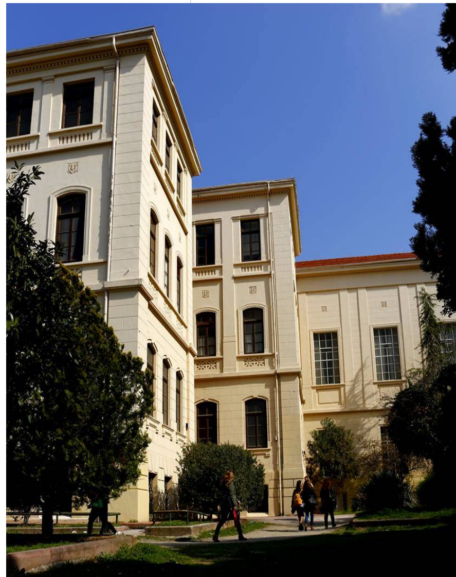
Αίθριο, Κτίριο Παλαιάς Φιλοσοφικής Σχολής
