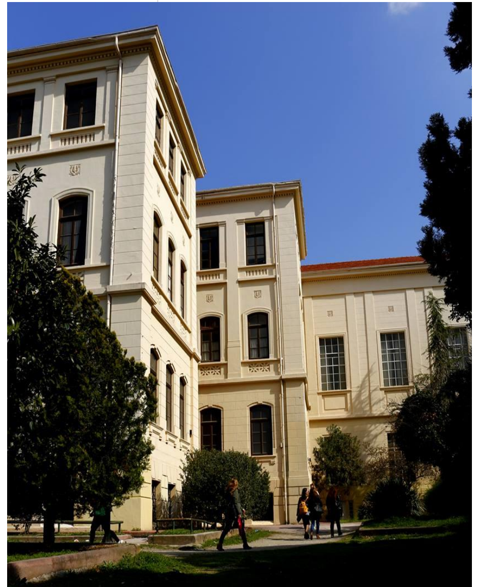
Αίθριο, Κτίριο Παλαιάς Φιλοσοφικής Σχολής
