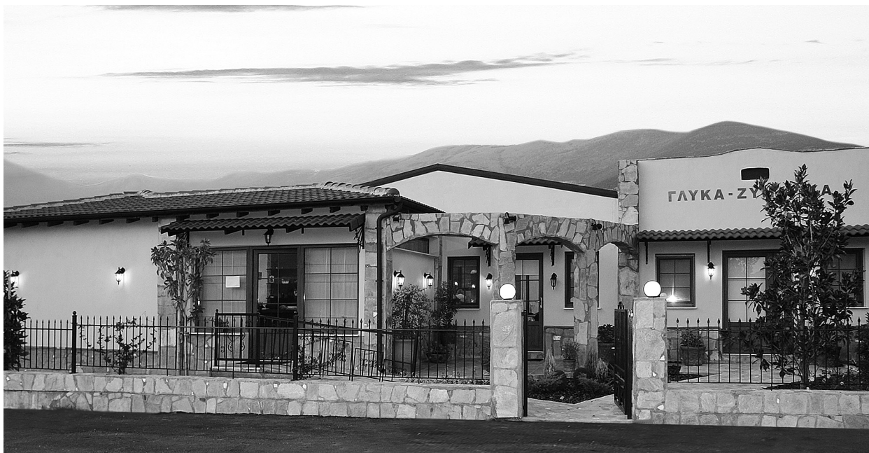
Κτηριακές εγκαταστάσεις Γυναικείου Παραγωγικού Συνεταιρισμού Κοκκινογείων Δράμας.
